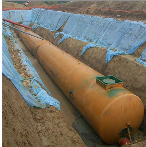
Abb. 3.29 Gemeinschaftliche unterirdische Regenwasserzisterne in einem Wohngebiet [Fraunhofer IGB]
