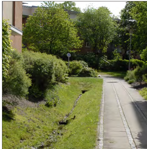
Abb. 3.10 Beispiel für die Ableitung von Regenwasser über eine offenen Graben in Hamburg [MUST Städtebau]
