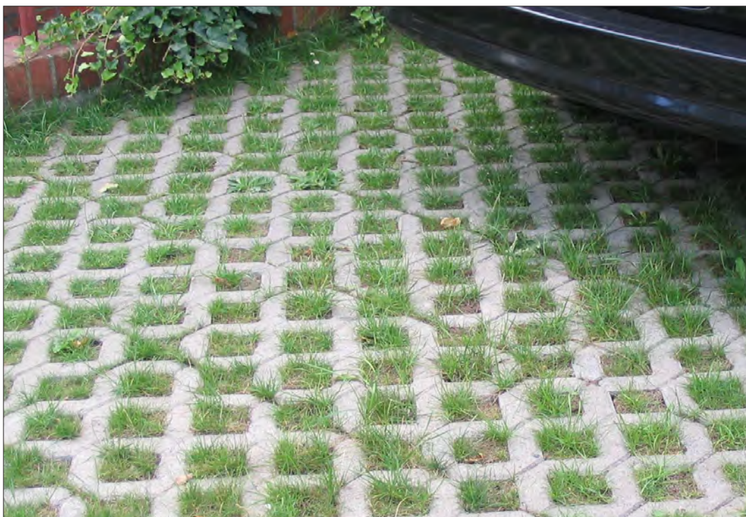
Abb. 5.15 Rasengittersteine in einem Bremer Wohngebiet [K. Kreuzer]
