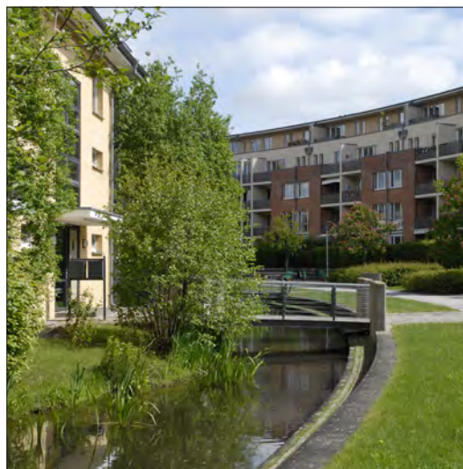
Abb. 3.5 offene Wasserflächen in einem Hamburger Wohngebiet [MUST Städtebau]
