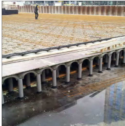
Abb. 3.22 Rigolen zum Wasserrückhalt über der Tiefgarage Kruisplein in Rotterdam [Gemeente Rotterdam]
