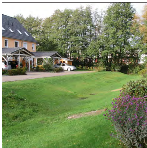
Abb. 3.6 Muldenversickerung in einem Wohngebiet in Bremen [K. Kreuzer]
