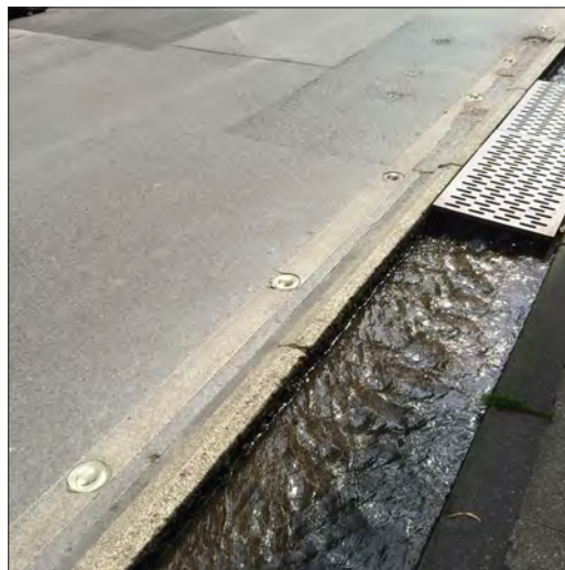
Abb. 3.11 Beispiel für die Ableitung von Regenwasser über eine offene Kastenrinne im Straßenraum in Aachen [MUST Städtebau]
