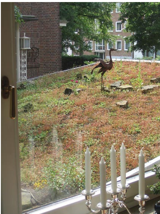
Begrüntes Garagendach in Schwachhausen
