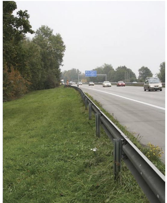
Versickerung am Straßenrand „über die Schulter“
