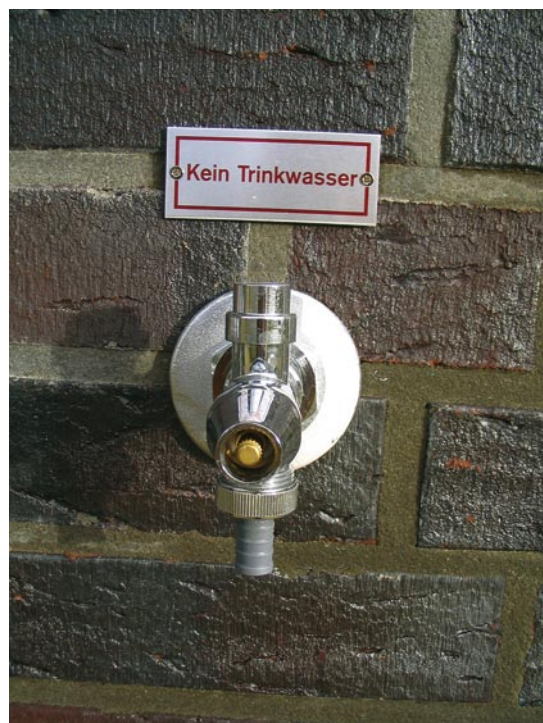
Gekennzeichnete und gesicherter Außenwasserhahn
