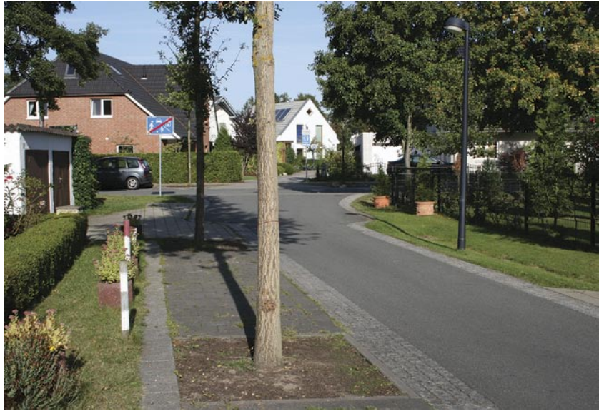
Oberflächliche Ableitung des Regenwassers in Borgfeld Ost über Mulden, Baumscheiben und offene, versickerungsfähige Seitenräume. Auf einen Regenwasserkanal konnte verzichtet werden.
