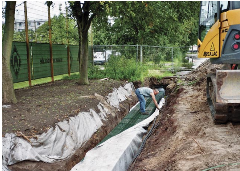
Einbau von Sickerblöcken am Bremer Weserstadion
