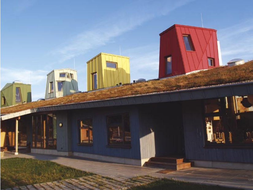
Begrüntes Dach der Kindertagesstätte „Das Entdeckerhaus“ im Technologiepark. Aus dem Bremer Förderprogramm für Dachbegrünung gab es einen Zuschuss.
