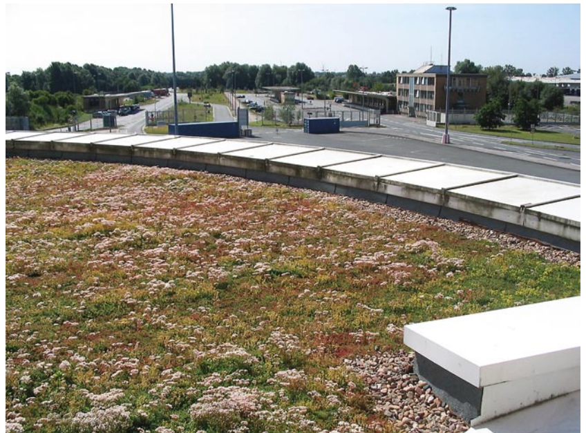
Angenehmes arbeiten im Neustädter Hafen. Die Mitarbeiter der Bremer Lagerhaus Gesellschaft und die Zech Industriebau profitieren vom Bremer Förderprogramm für Dachbegrünung.
