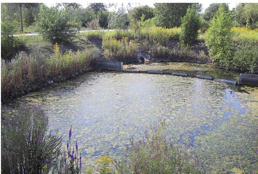
Absetzbecken mit schwimmender Tauchwand in der Airportstadt Ost acht Jahre nach der Fertigstellung.
