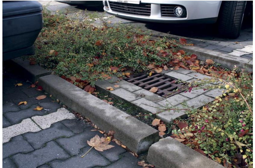
Entwässerung eines Supermarktparkplatzes in Walle über eine Mulde mit Notüberlauf in den Mischwasserkanal
