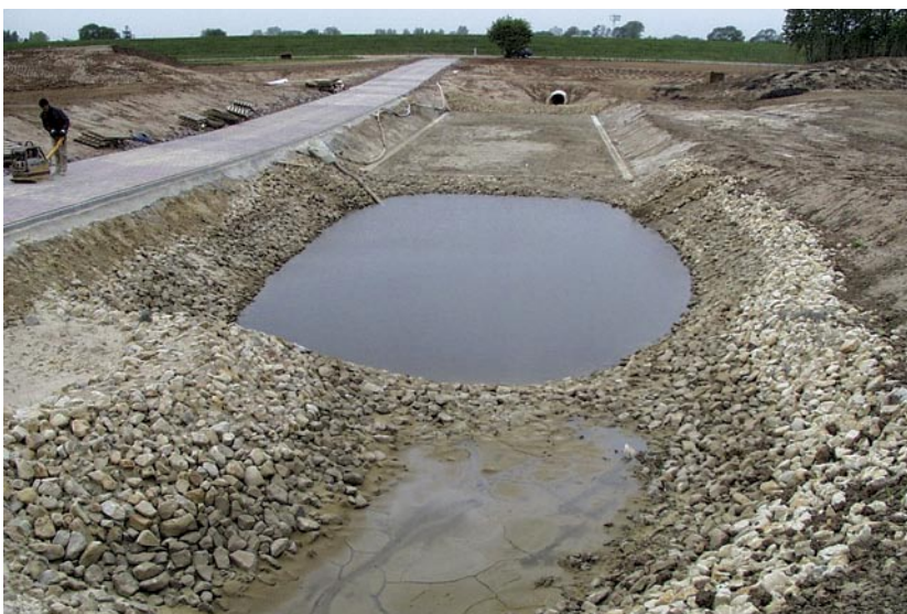
Regenkläranlage im Gewerbepark Hansalinie während der Bauphase
