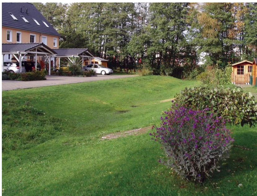
Mulden-Versickerung in Brokhuchting
