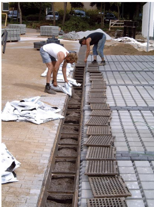
Einbau einer Sickermulde mit Substrat
