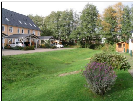
Muldenversickerung in Brockhuchting (Quelle: DER SENATOR FÜR UMWELT, BAU, VERKEHR)
