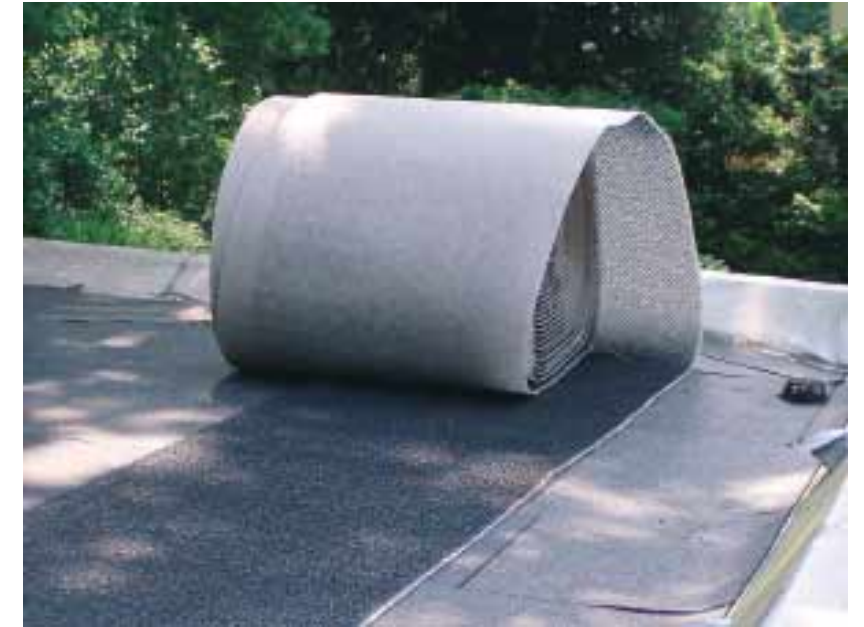
Je nach bautechnischer Ausgangslage müssen unterschiedliche Materialschichten auf dem Dach ausgebracht werden. Hier wird auf Gummischutzmatten die Drän- und Bewässerungsschicht verlegt.
