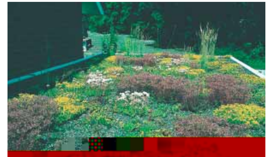
Zwei Jahre nach der Anlage hat sich auf dem Carportdach eine dichte Pflanzendecke entwickelt.
