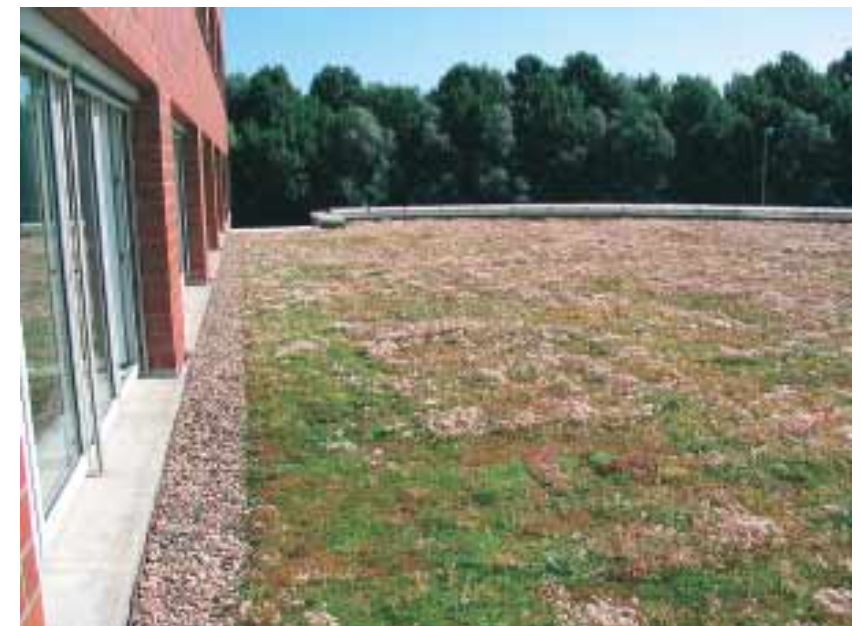
Ein Kiesstreifen am Bürogebäude der Bremer Lagerhaus Gesellschaft im Neustädter Hafen trägt zum Brandschutz bei.
