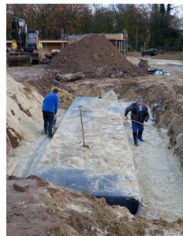
Abbildung 21: Übersichtsskizze der neu gestalteten Umgebung der Recyclingstation und Einbau der Regenrückhaltung im Bereich der Grünwegeverbindung
